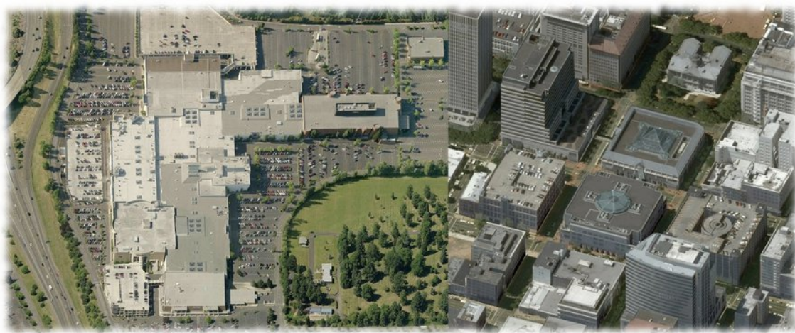
Due distretti industriali. A sinistra, l'Intel Ronler Acres a Hillsboro, Oregon, realizzato in un'area a sola destinazione industriale. A destra, l'edificio sede della Vestas Wind Systems per il nord America, inserito nella rete viaria e pedonale di Portland, nel contesto di un quartiere in cui vivono anche lavoratori nel settore delle nuove tecnologie.
